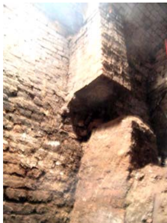
Afbeelding 2: rollaag en L-vormige poer in het middeleeuwse werk van de beerkelder.
